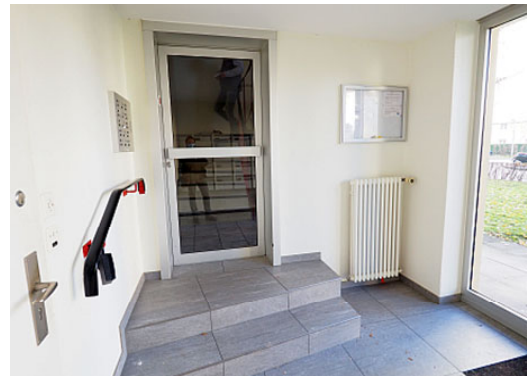
Hauseingang/Windfang im EG
